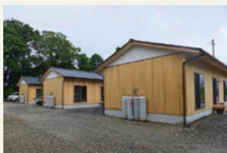
木造の応急仮設住宅
